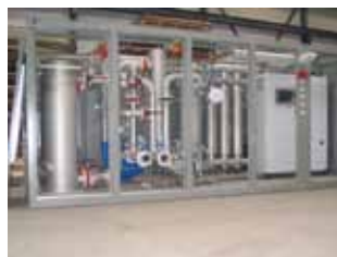
TCR in aanbouw
